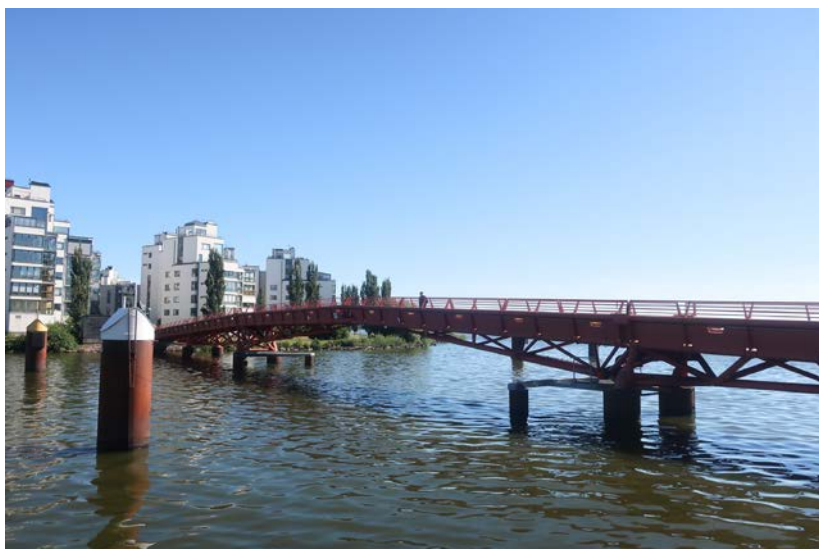
Lillåuddsbron, en öppningsbar cykel- och fotgängarbro från Östra Hamnen till Lillåudden
